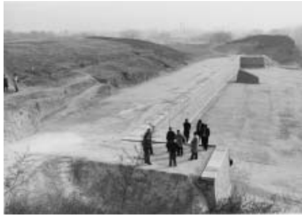
修復工事中の含元殿基壇
